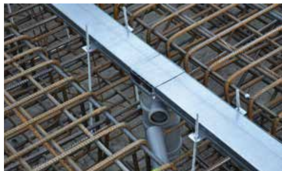
Anwendungsbeispiel 1 Montage mit Rinnenaufständerung
